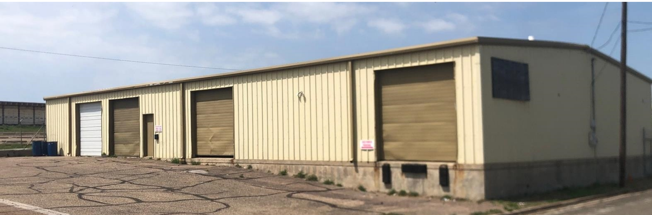
1 Dock level door
